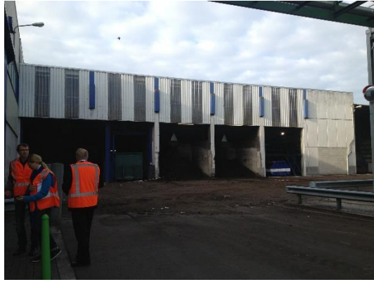
発酵残渣の搬出口
