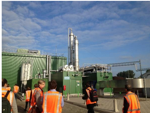
メタンガス精製装置
